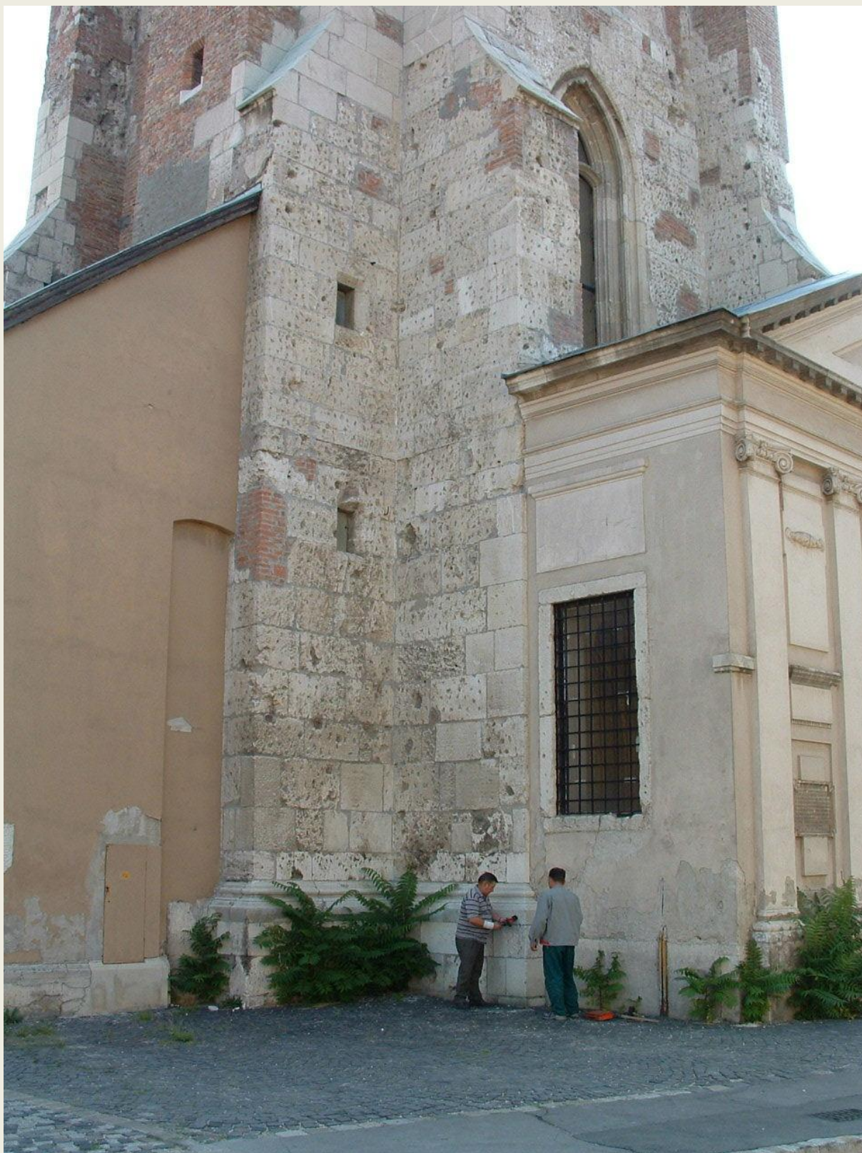
5. fotó A mérés előkészítése a Magdolna torony földszintjén
