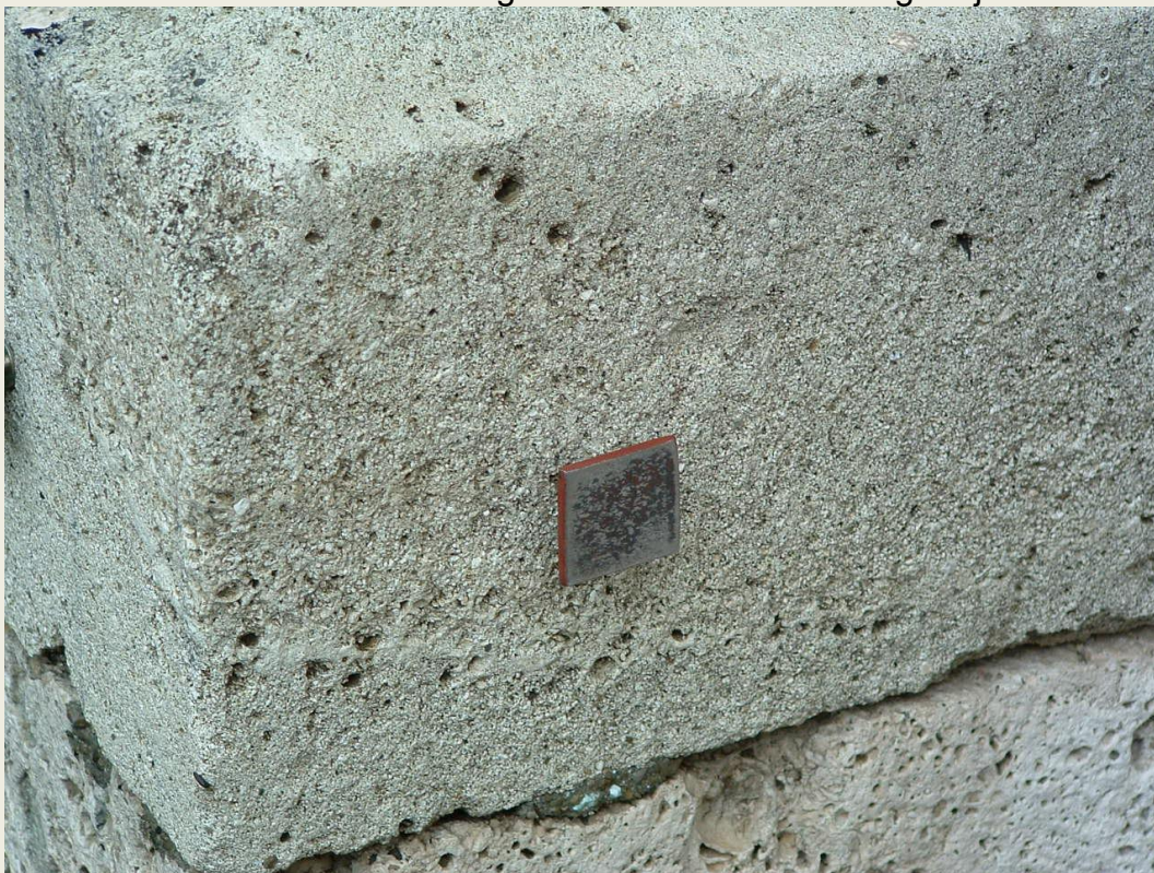
3. fotó: A mérőlemez rögzítése
