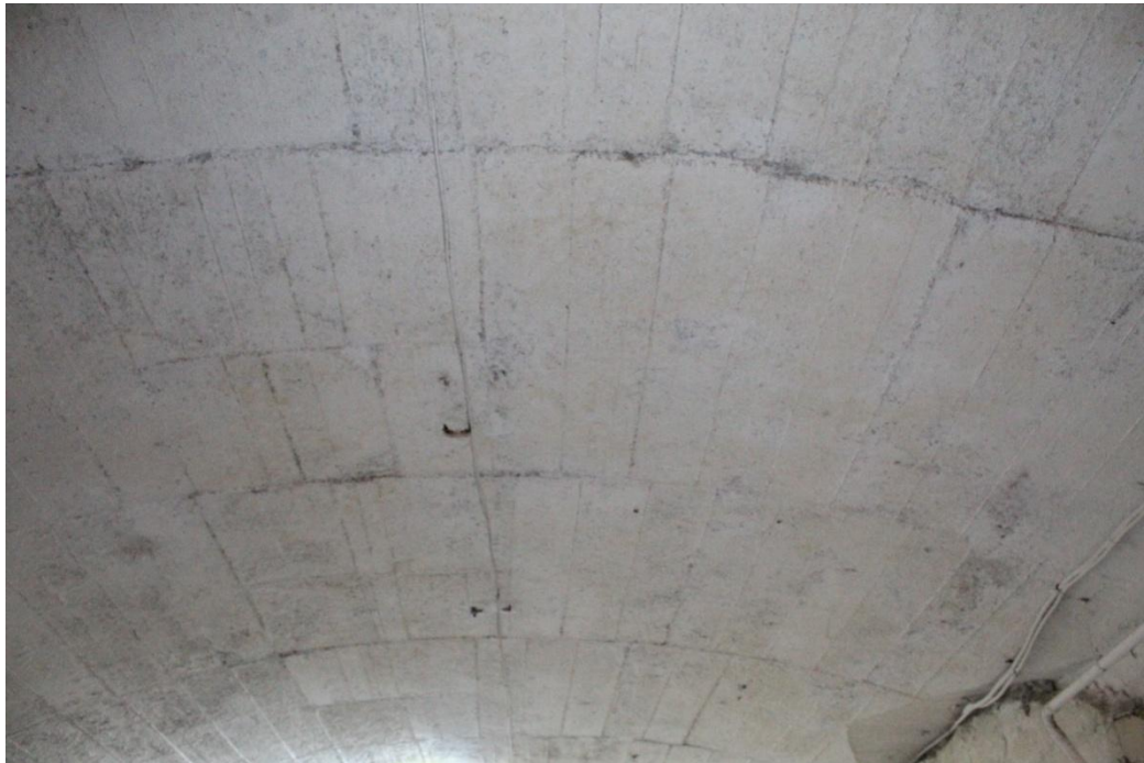
4. A pincejártat főtéjének biztosítása vasbeton boltívvvel
